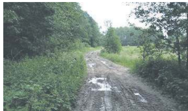
Tak teraz wygląda nieutwardzona część drogi w Podhuciu.
