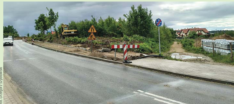
Budowa ścieżki rowerowej z Zacisza do Bartąga
