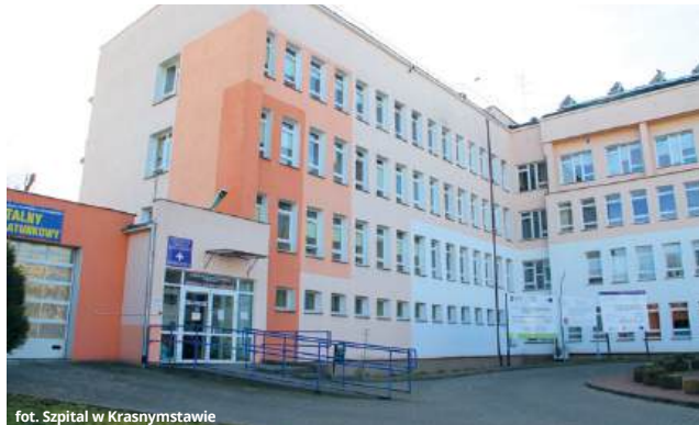
foto: Szpital w Krasnymstawie
