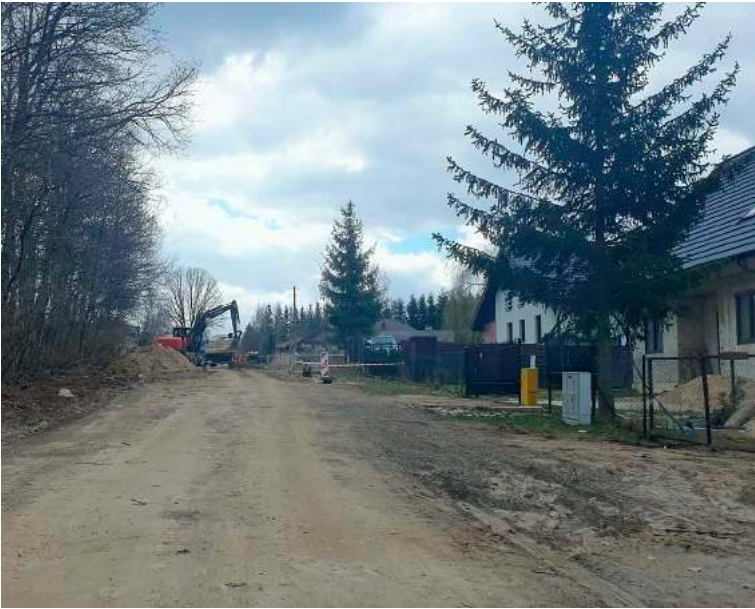
Jedną z 17 gruntówek, które zyskają bitumiczną nawierzchnię będzie ulica Szafirowa
