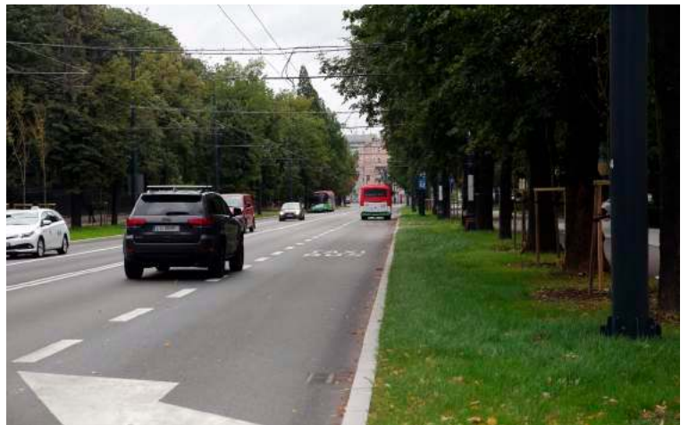
Przebudowa Alei Raclawickich wraz z ul. Lipową i Poniatowskiego trwała od kwietnia 2020 roku do sierpnia 2021 roku. Kosztowała ponad 100 mln zł, z czego 85% stanowiło unijne dofinansowanie. Wykonawcą prac było konsorcjum firm: Przedsiębiorstwo Robót Drogowych Lubartów oraz Komunalne Przedsiębiorstwo Robót Drogowych z Lublina
