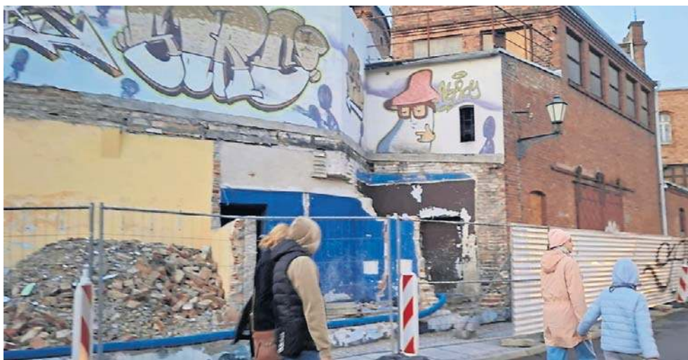
Cała ściana browaru od strony ul. Piernikarskiej i Wielkie Garbary właśnie znika z krajobrazu starówki. Jest rozbierana, bo tu powstanie nowa elewacja i wejście
