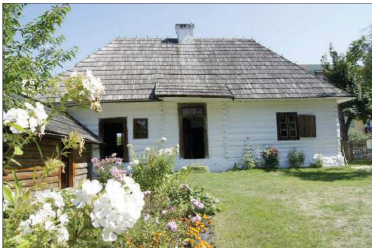
▲ Budynek mieszkalny skansenu Zagroda Sitarska przy ul. Nadstawnej 32 (filia Muzeum w Biłgoraju)
