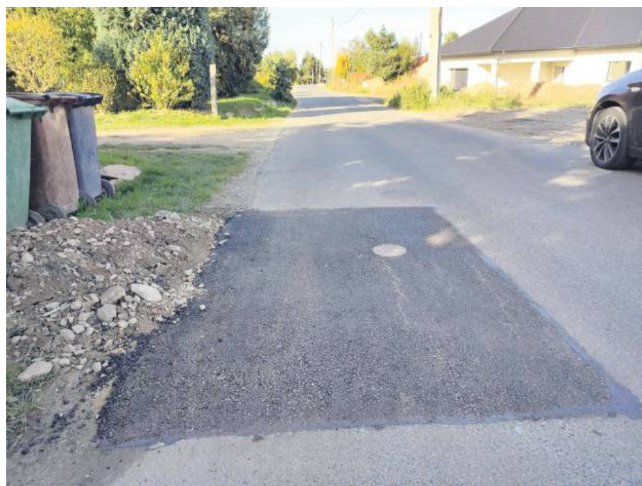
Przez pewien czas wycięty był fragment jezdni na ul. Sosnowej w Gęsińcu. Kilka dni temu miejsce to zostało porządnie załatane równą warstwą asfaltu i jest praktycznie niezauważalne dla jadących
