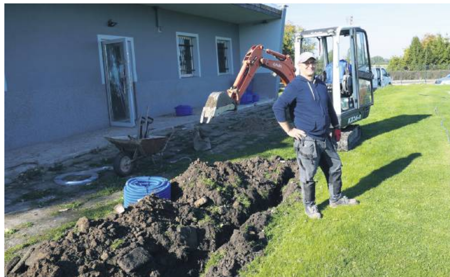
Firma Jacka Niedzieli ze Strzelina montuje maszty oświetleniowe na boisku w Jegłowej i Przewornie
