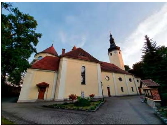
Kościół pw. Wniebowstąpienia NMP w Otmęcie.
