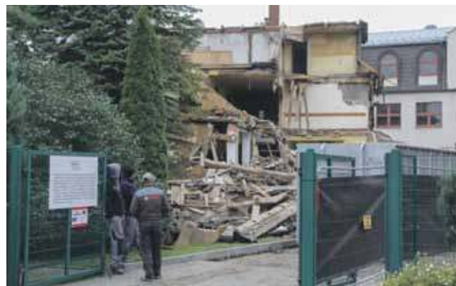
Ekipa rozbiórkowa robi miejsce pod nowe skrzydło szkoły muzycznej.
