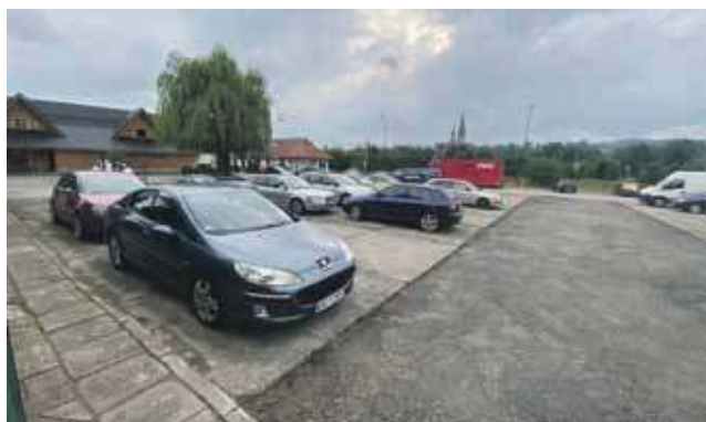
Wyremontowany parking przy ulicy Piłsudskiego
