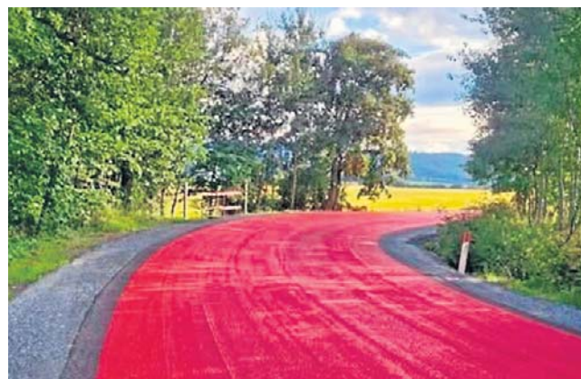
Specjalna powłoka w kolorze czerwonym ostrzega przed zakrętem i poprawia przyczepność auta do jezdni. W Czechach do bardzo popularne rozwiązanie.
