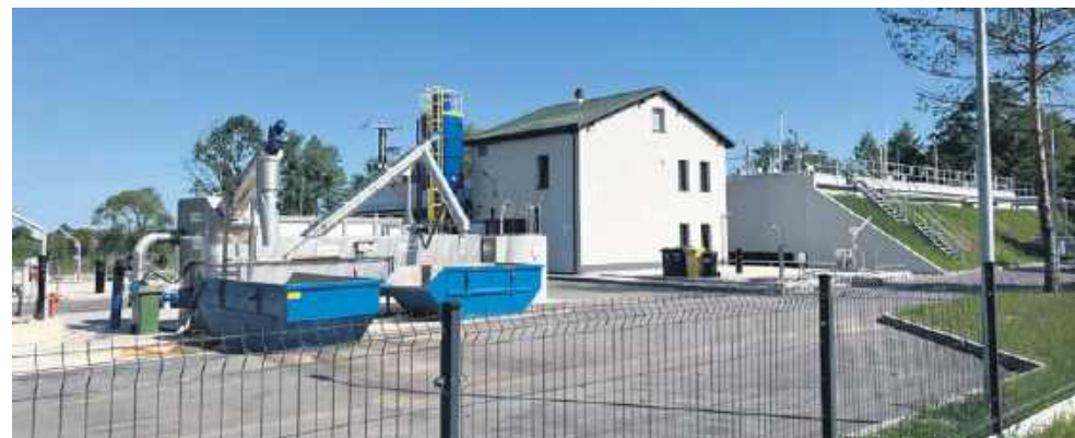
Zmodernizowana oczyszczalnia ścieków w Starych Siołkowicach
