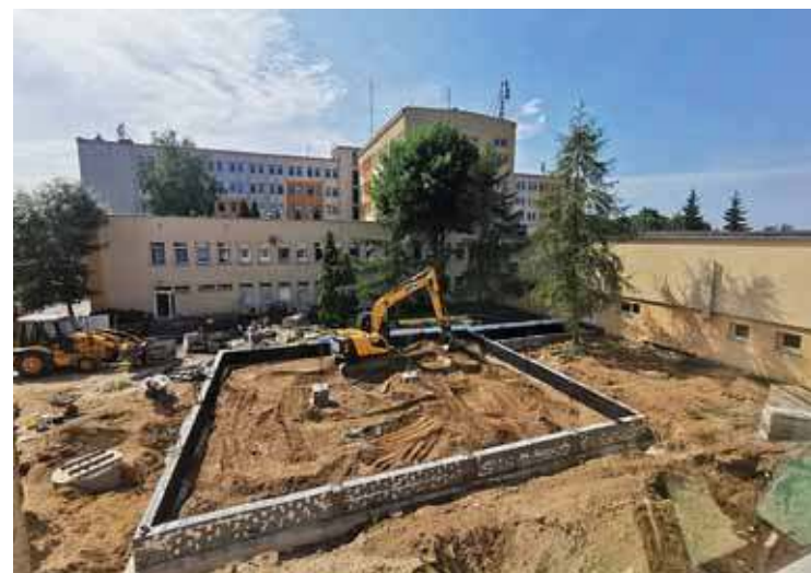
Budowa nowego skrzydła szpitala
