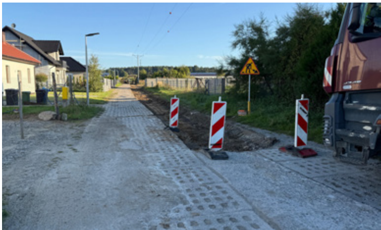
Przebudowa ul. Zbożowej w Brzegu Dolnym.
