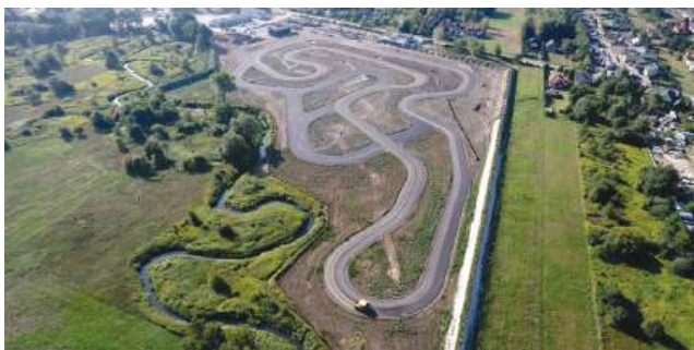
Trwa układanie warstwy bitumicznej. Powstanie też nowoczesny padok – czyli serce toru wyścigowego. Będzie to miejsce gdzie zespoły budują swoje zaplecze na zawody.
