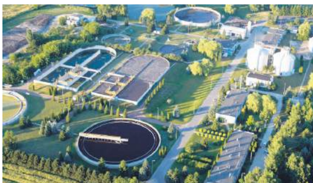
W punkcie zlewnym montowana jest kontenerowa stacja przyjęcia ścieków ze zbiorników bezodpływowych, a na dodatek trwa wywóz osadów na pola. Stąd nieprzyjemny zapach. Fot. PGK
