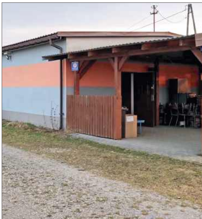
Świetlica w Rzemieniu z zewnątrz
