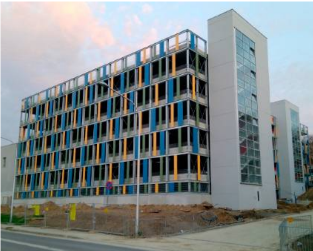
Budowa wielopoziomowego parkingu UM powoli dobiega końca
