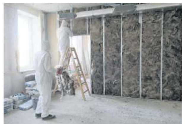
Prace na budowie są już bardzo zaawansowane
