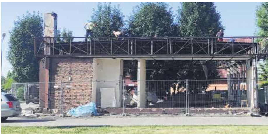
W Wiązowie przy ulicy Strzelińskiej trwa rozbiórka tzw. sklepu żelaznego
