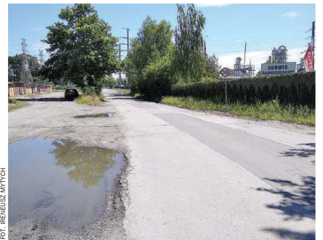
Planowana modernizacja ulicy Spacerowej w Stalowej Woli ma objąć jej rozbudowę i budowę nowego odcinka
