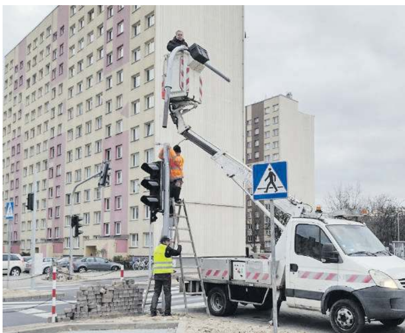
Prace przy nowej sygnalizacji świetlnej obok dworca PKS w Stalowej Woli
