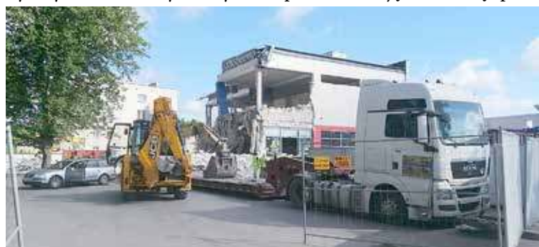
A to już zdjęcia historyczne, pierwsze dni wyburzania dawnego domu handlowego
