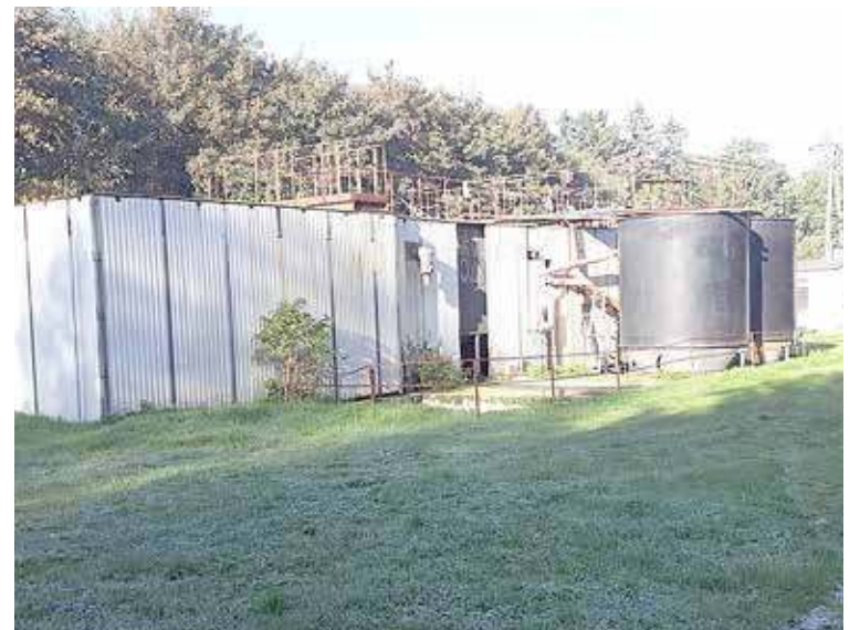
Na zdjęciu stara oczyszczalnia ścieków w Mostach pod Goleniowem Fot. Gmina Goleniów
