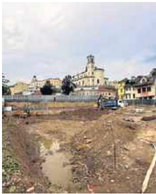
Ruszyła budowa nowej galerii handlowej
