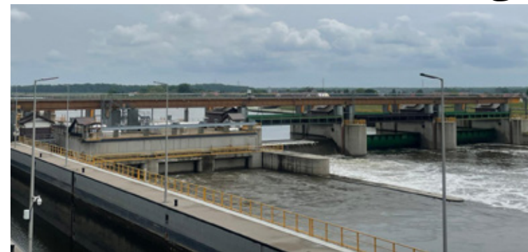
Stopień Malczyce to nie tylko budowla hydrotechniczna, chroniąca przed powodzią i umożliwiająca żeglugę. To również nowoczesna elektrownia wodna.
