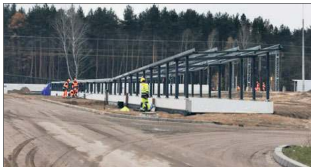
Na ukończeniu są prace związane z budową podziemnego przejścia do stacji Biała Podlaska Wschodnia
