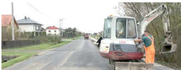
W Obszy roboty drogowe będą na 12 odcinkach o łącznej długości ponad 8 kilometrów
