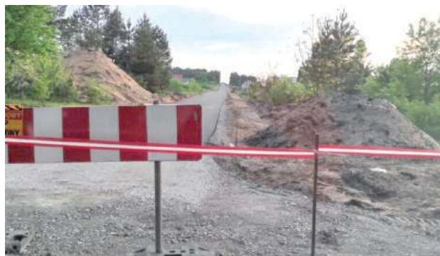
Planowy koszt budowy drogi w II linii zabudowy w Hedwiżynie oszacowano na kwotę ok. 5,6 miliona złotych
