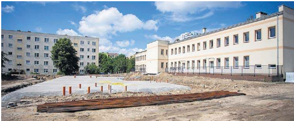
W rozbudowywanym żłobku przy ul. Andersa mają powstać 72 nowe miejsca dla dzieci
