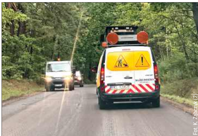
Kilka dni temu drogowcy zrywali asfalt.
