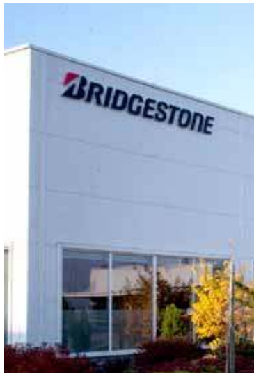
Bridgestone wciąż się rozbudowuje. Teraz powstanie magazyn surowców, hala produkcyjna i budynek do sprawdzania parametrów opon
