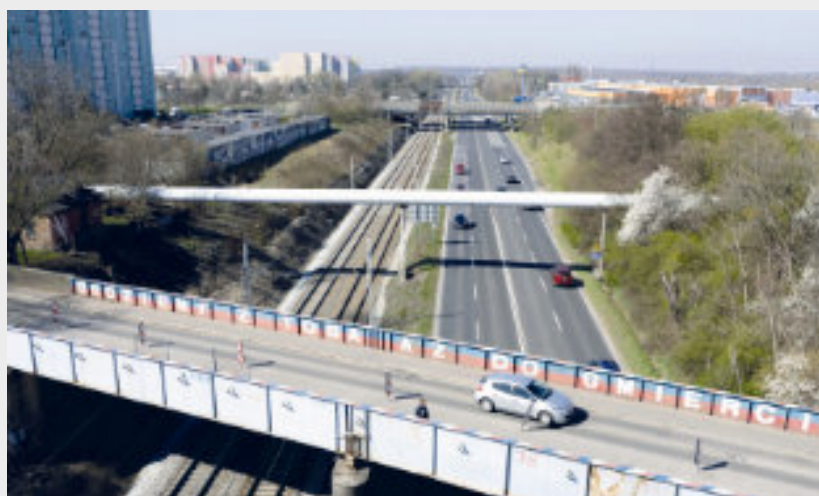
► Objęty przebudową wiadukt Fot. UM Zabrze
