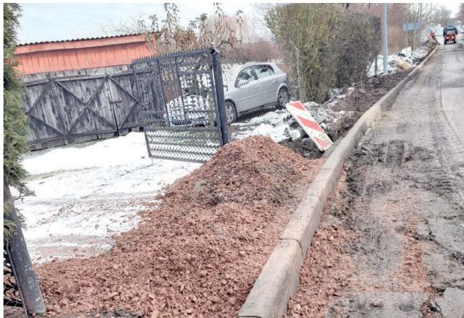
Prace ruszyły w piątek, 15 grudnia. Robotnicy zerwali asfalt i już tego dnia przez kilka godzin mieszkańcy mieli utrudniony dojazd do posesji
