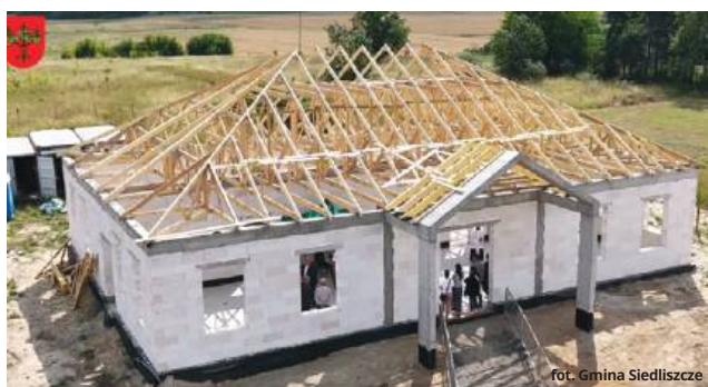
Budowa obiektu przebiega bardzo sprawnie
