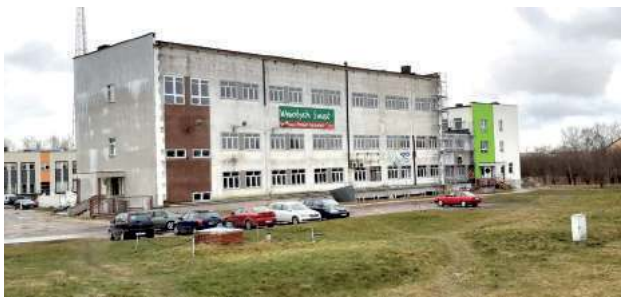
Na zewnątrz widzimy tylko część nowej elewacji. A wg pierwszych planów bursa miała być skończona już we wrześniu 2022 r.
