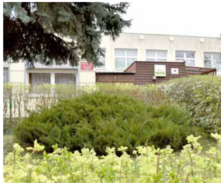
Latem na budynku Żłobka Miejskiego Leśna Polana wymienione zostanie pokrycie dachu
