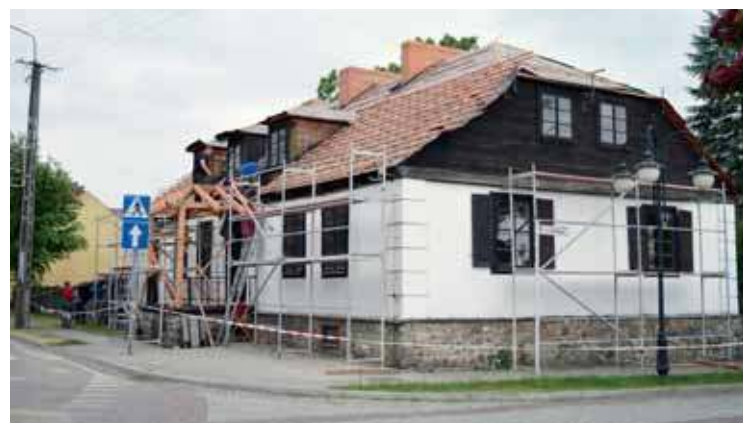
Prace przy przebudowie muzeum w Biezuńu
