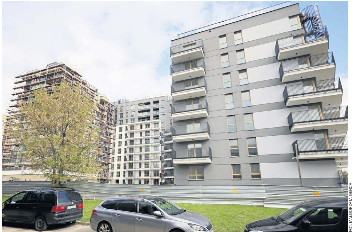
Powstający przy ul. Kameralnej Nowy Czechów będzie liczył 11 kondygnacji i 246 mieszkań. To pierwsza inwestycja mieszkaniowa w Lublinie posiadająca certyfikat BREEAM
