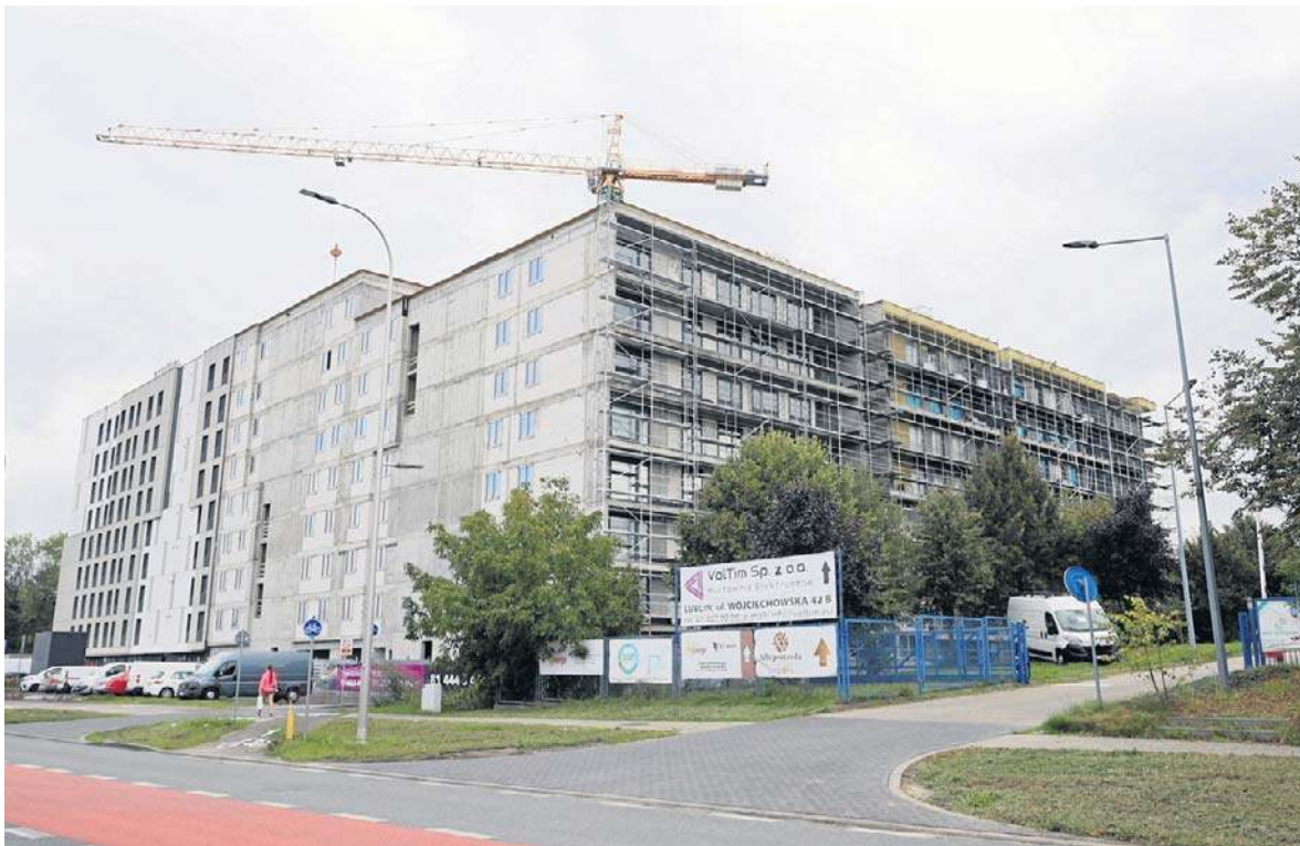
W drugim etapie inwestycji przy ul. Bohaterów Monte Cassino Żagiel-Dom odda do użytku 158 mieszkań o powierzchni od 28 do 104 m kw
