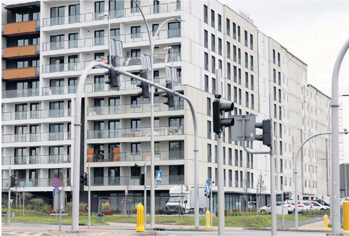
Pierwsi mieszkańcy Wojciechowskiej Square już korzystają z gotowych budynków osiedla. W następnych etapach inwestycja wzbogaci się o kolejne lokale o zróżnicowanych metrażach
