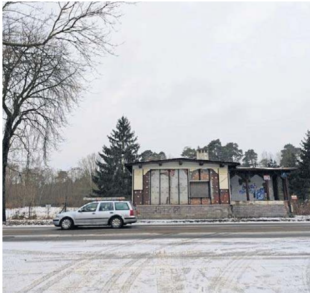
Rogatki przy Szosie Bydgoskiej 7 zostaną poddane adaptacji z rewitalizacją, z zachowaniem zabytkowej substancji i uczynieniem pierwotnego wyglądu
