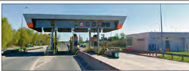
Dawne bramki na autostradzie A4 w rejonie Krapkowic niebawem zostaną rozebrane.
