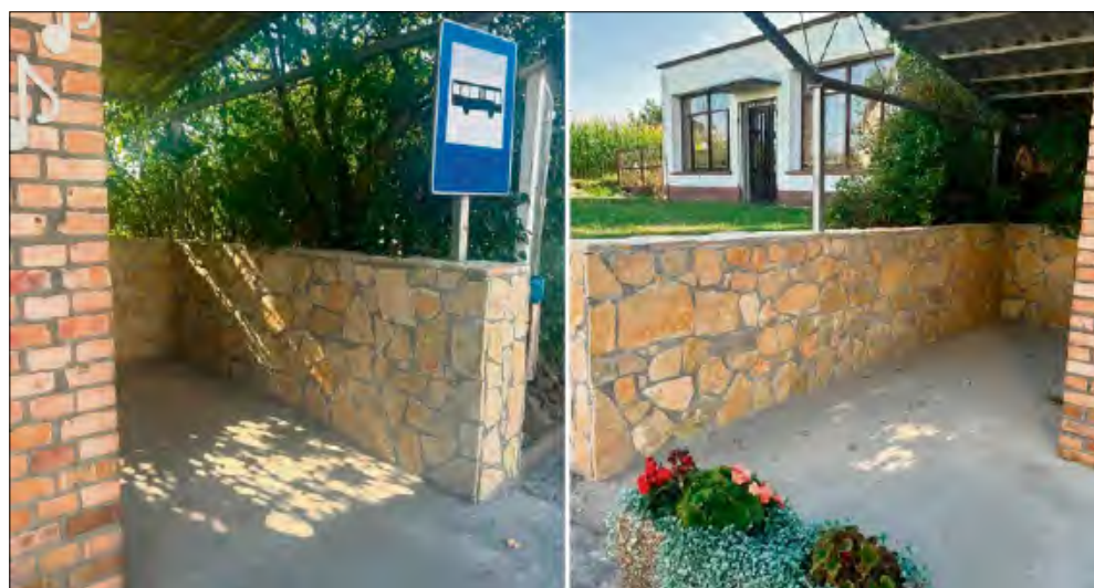
Remont przystanku stanowi kolejne działanie wykonane w ramach lokalnych inicjatyw.
