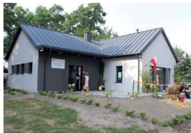
Mieszkańcy Dęby w końcu doczekali się świetlicy wiejskiej. Dawniej w tym miejscu działała szkoła podstawowa. Obiekt przeszedł gruntowną modernizację. Uroczystego otwarcia dokonano w ubiegłą niedzielę
