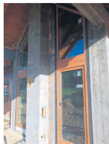
Okna PCV ze skosami w okleinie drewnopodobnej.
