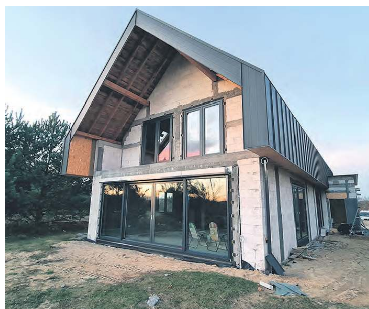
Na parterze aluminiowe drzwi typu slide z roletą podtynkową, na piętrze okna balkonowe PCV.
