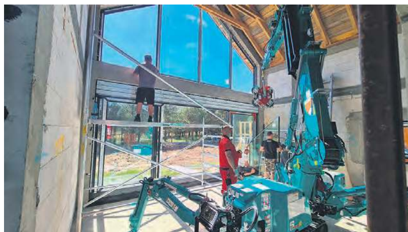
Montaż okien wielkogabarytowych z użyciem dźwigu.
