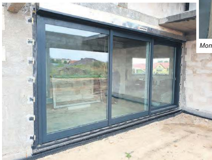
Aluminiowe drzwi przesuwne z roletą podtynkową.
