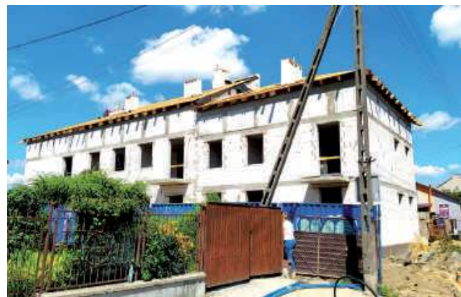
Ubiegłoroczna rozbiórka poprzedniej zrujnowanej kamienicy odsłoniła drugi poziom niezainwestowanych piwnic, ale i konieczność znacznego wzmocnienia podłoża, na co w sumie zużyto 660 ton betonu
