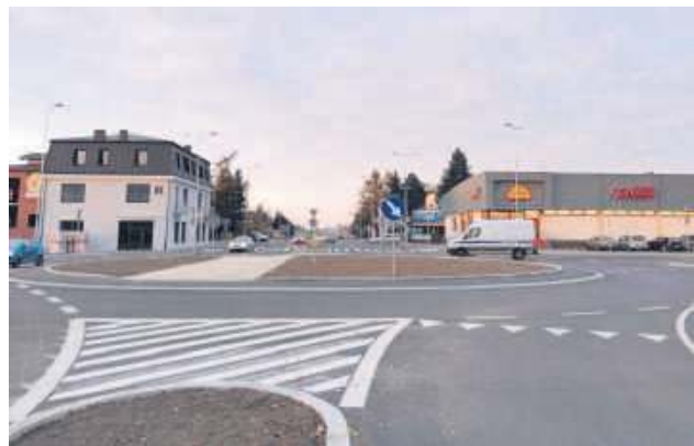
Skrzyżowanie ulic Lubelskiej z Wiejską, Wojska Polskiego i Marszałka J. Piłsudskiego zostało przebudowane na rondo. Fot. UM Zamość
