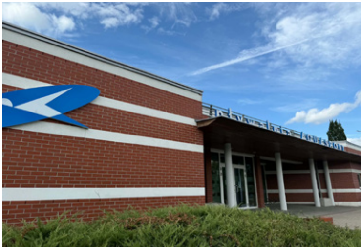
Pływalnia w Brzegu Dolnym zaprasza!
