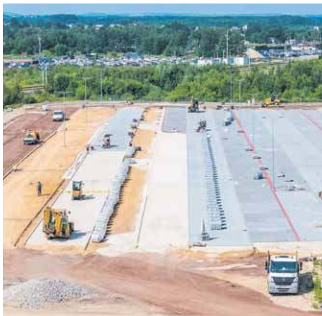
Powstaje 1100 nowych miejsc postojowych
