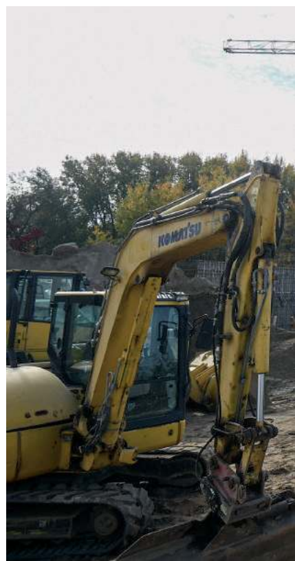
Budowana szkoła ma być przeznaczona dla 750 uczniów
