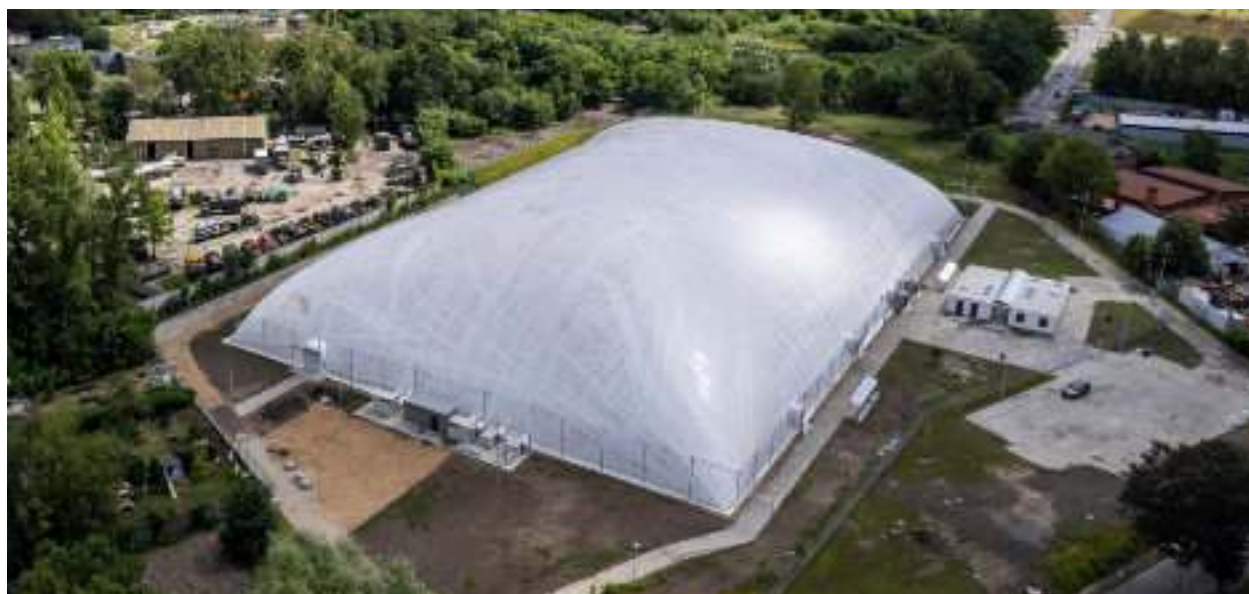
► Pneumatyczna hala przykrywająca boisko ma wymiary 115 na 74 metry Fot. UM Zabrze
