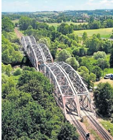
Trwa kolejny etap modernizacji linii 94
