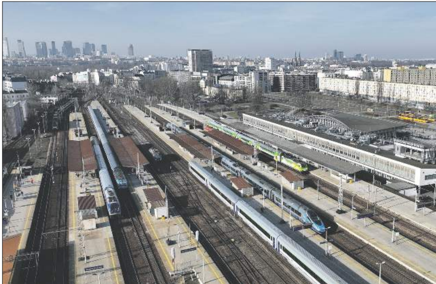
➤ Dworzec Warszawa Wschodnia (fot. PKP PLK)
