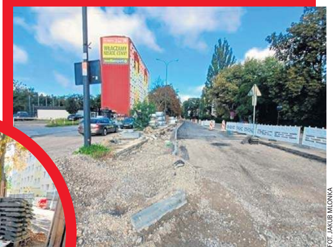
Końca robót nie widać, robotników też...
