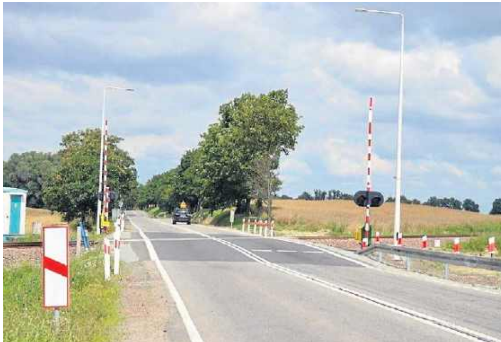
Przy okazji budowy ścieżki odbędzie się przebudowa przejazdu w Konieczwałdzie
