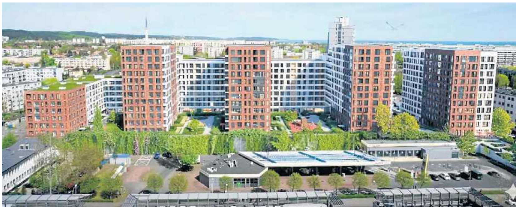
Taki budynek ma powstać w miejscu Alfa Centrum
