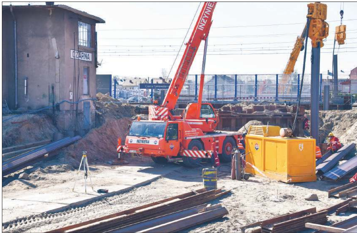
Budowa wiaduktu w Czarnej i jej okolice to wciąż jeden wielki plac budowy. Prace potrwają do końca roku.
