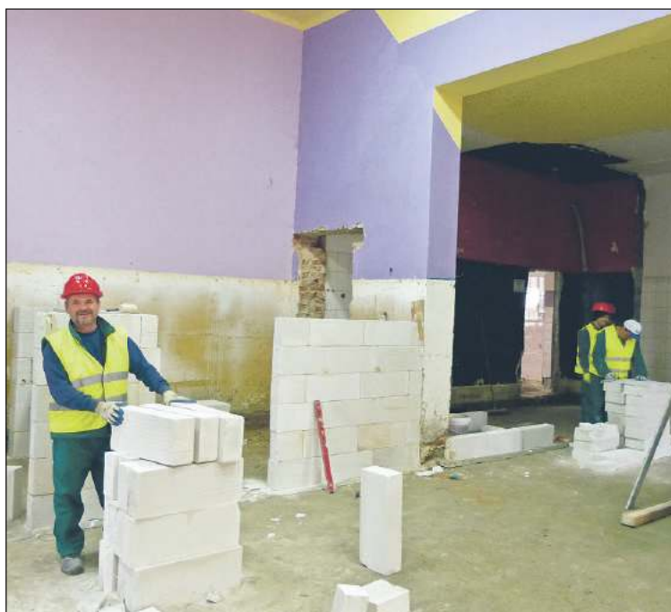
Budynek remizy w Bobrowej jest jednym z sześciu remontowanych.
