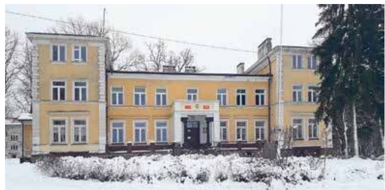
Na remont czeka także elewacja szkoły.
