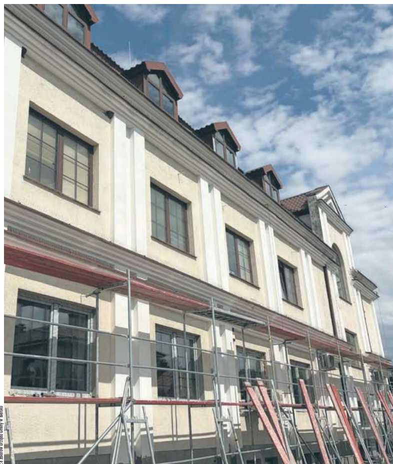
Budynek Urzędu Gminy Bielsk przechodzi remont. Prace powinny zakończyć się do końca listopada 2026 r.
