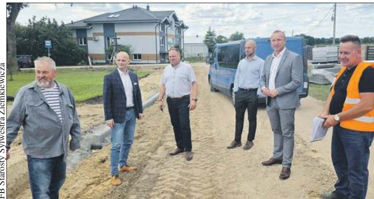
Na placu budowy odbyło się spotkanie robocze z udziałem przedstawicieli samorządów zaangażowanych w realizację zadania
