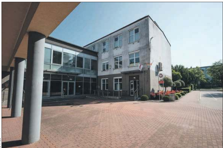
Budynki III LO przejdą modernizację
